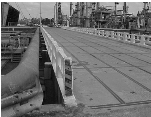
FIGURA 1- VISÃO GERAL DA PONTE P-A
